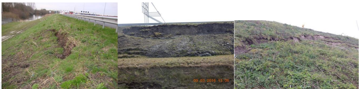
Foto: Afschuiving van talud.
