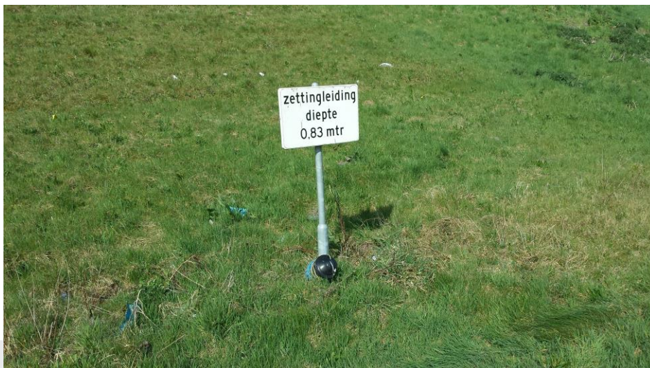
Foto: Duidelijk markering zettingsleiding.
