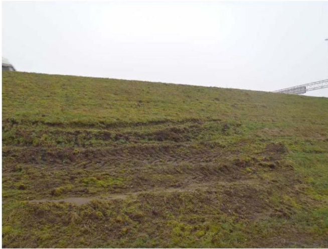
Foto: Maaischade aan afdeklaag.
