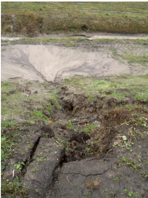
Foto: Erosie van afdeklaag.
